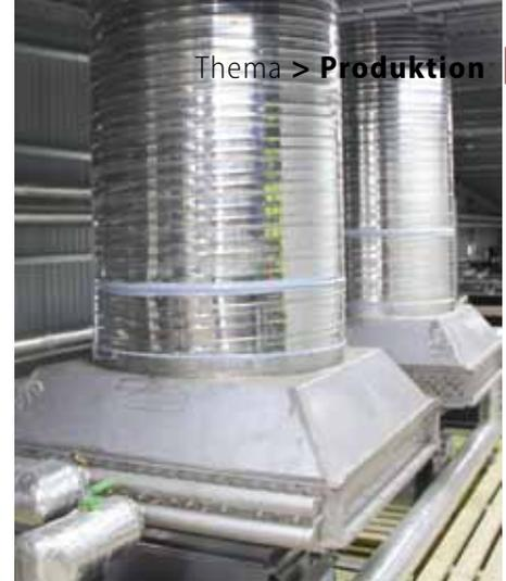
Wärmetauscher in den ersten fünf Zonen dienen der Energierückgewinnung
