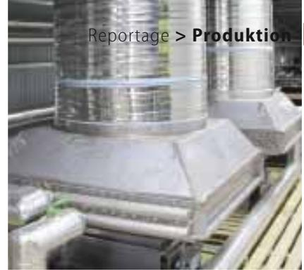
Wärmetauscher in den ersten fünf Zonen dienen der Energierückgewinnung
