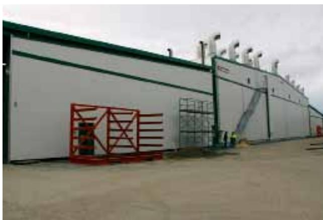
Mit diesem Riesentrockner von Valutec können bis zu 110.000 m<sup>3</sup>/J Schnittholz getrocknet werden
